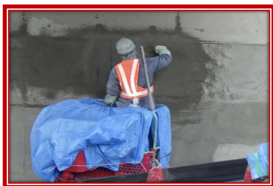
コテ仕上げ状況
