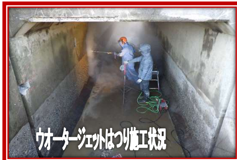
ウォータージェットはつり施工状況
