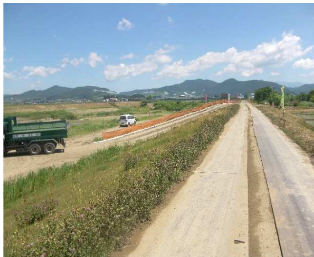
ダンプトラック走行状況
