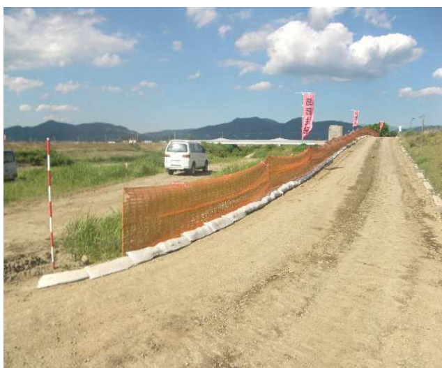
枕土嚢による路肩の明示
