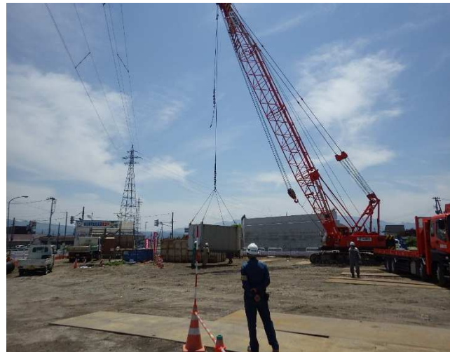
監視員配置による確認
