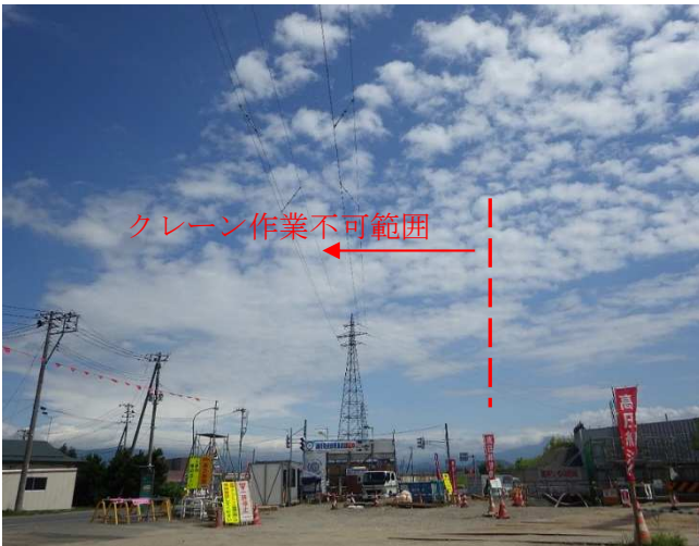
高圧線注意のぼりでクレーン作業範囲を明示
