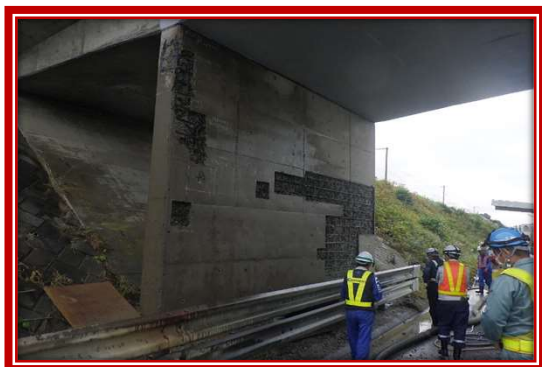
現場見学会状況
