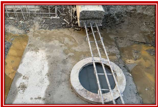
はつり完了状況
