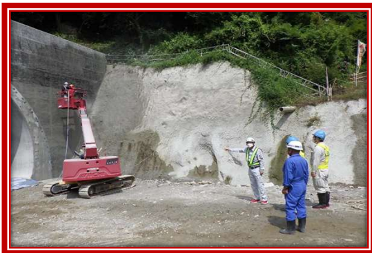
現場見学会状況
